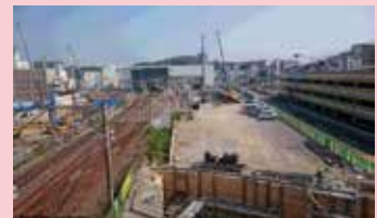
※現在、新幹線の駅が整備中の諫早駅の状況(駅の右側に新幹線の駅ができる予定です)
