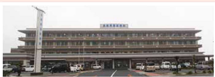
壱岐病院正面左手に増築棟を建築予定
